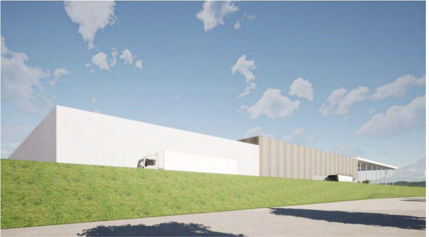
Enfin, le volume de stockage des produits finis se déployant sur 170 m de long, vient doucement se déformer grâce à de grandes « écailles » verticales, revêtues de bardage. Les failles ainsi engendrées, perçues depuis le Nord, apporteront la lumière naturelle dans la halle le jour et une fente lumineuse depuis l'autoroute la nuit. La façade côté ZAC reprendra le même bardage sur une façade plane, en phase avec l'aire de chargement des poids lourds qui la longera.
