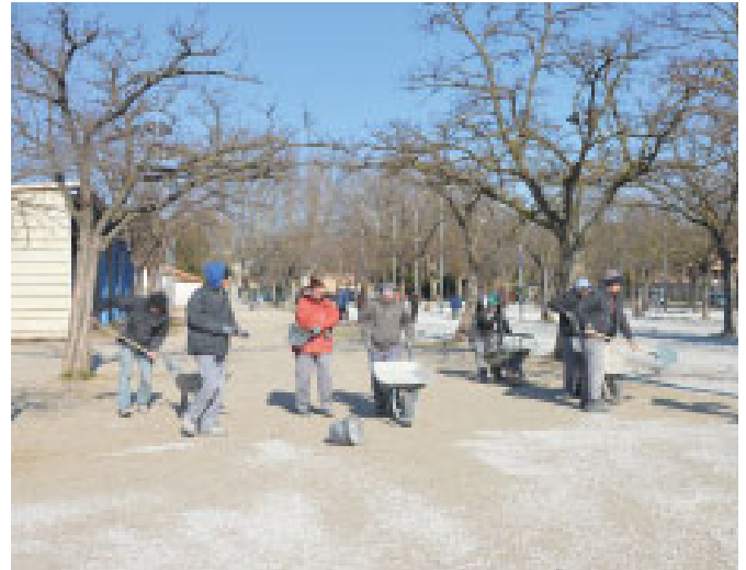
L'équipe du chantier d'insertion travaille au boulodrome
