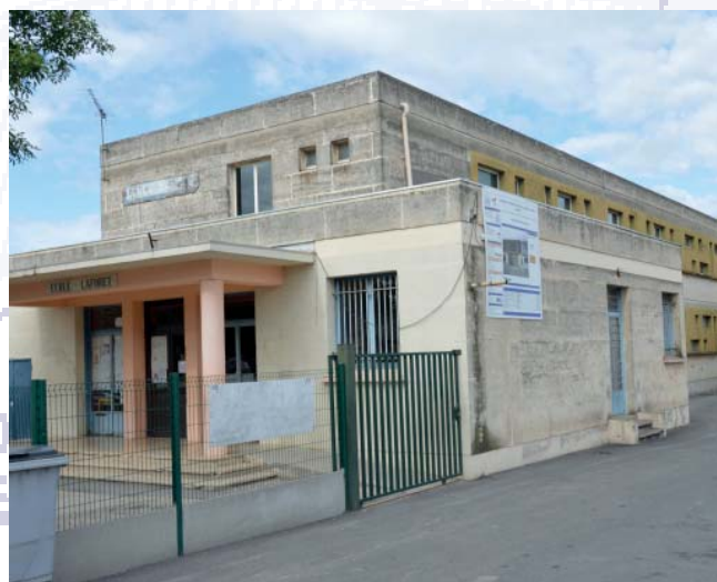
Réfection des façades
