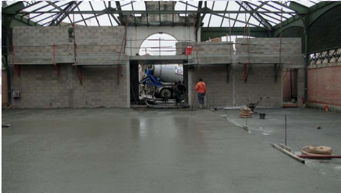
Mars 2016. Dalle du rez-de-chaussée, construction partielle de l’étage
