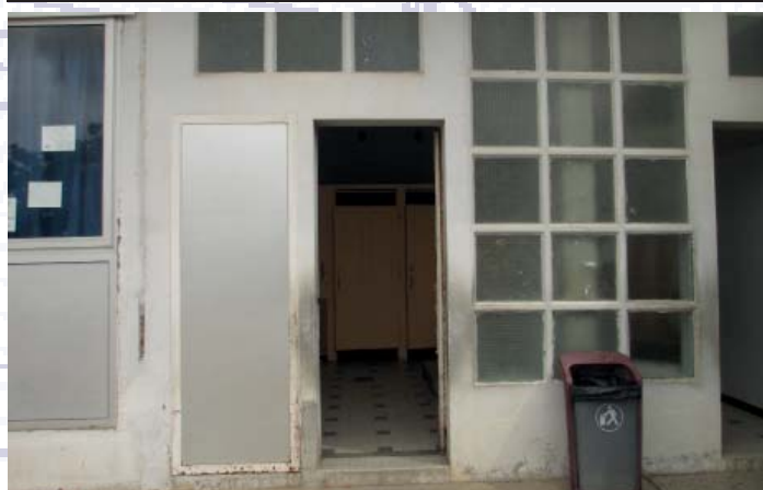
Rénovation/mise en sécurité de l'existant
