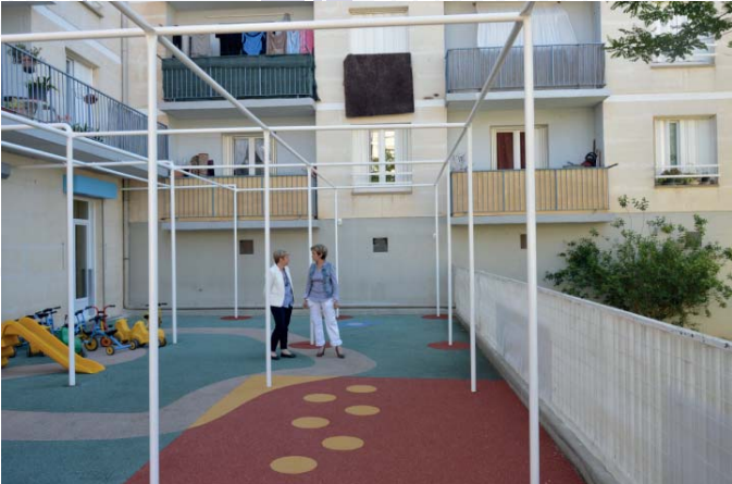
Réfection et mise en sécurité de la cour de la crèche
