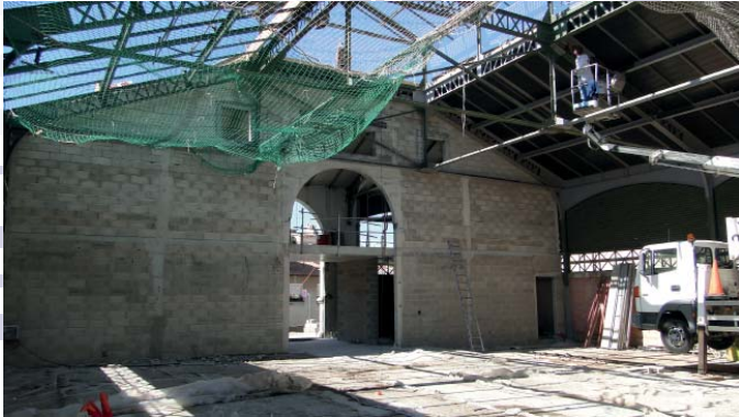
Mai 2016. Pignon interne et étage réalisés. Couverture en cours.
