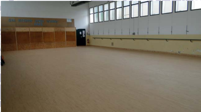
Rénovation du sol du gymnase de l'école Jules Ferry
