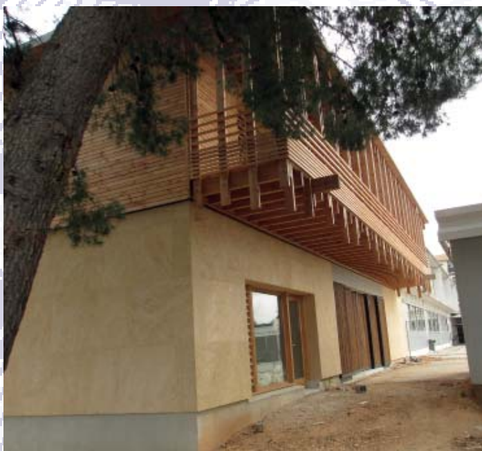
Construction de 3 classes
