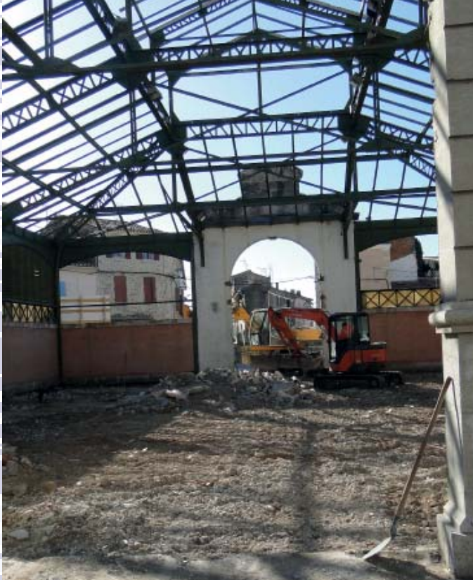
Février 2016. Démolition de la dalle existante
