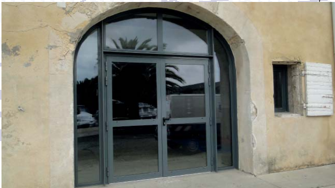
Rénovation de la salle du port
